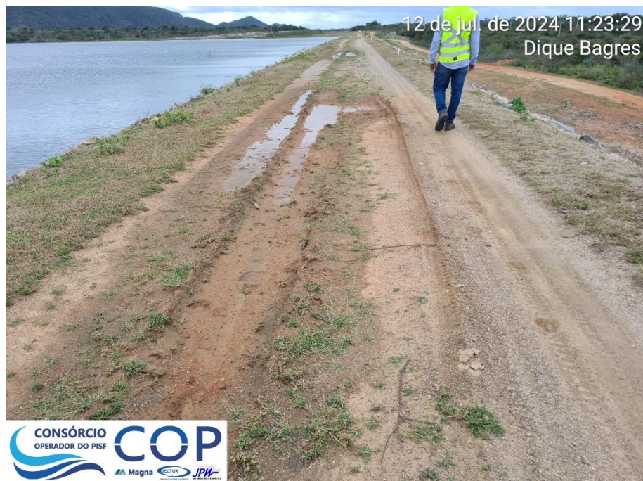
Foto 6.11: Vista do coroamento do dique. Sinais de tráfego de veículos.
