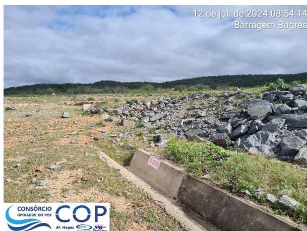
Foto 6.17: Canaleta construída conforme projeto – Ombreira direita.
