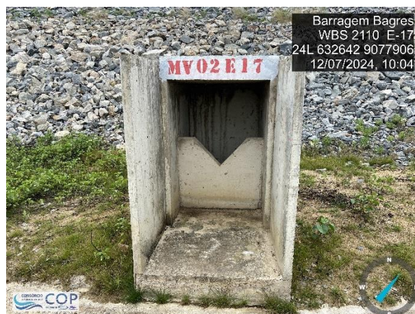
Foto 6.29: Medidor de vazão MV-02- Estaca 17+00.
