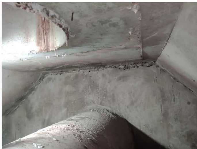
Aspecto final da parede após a retirada dos bicos e aplicação do tamponamento
