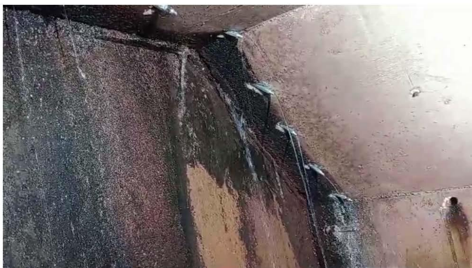
Bicos colocados. Observamos grande fluxo de água através dos bicos
