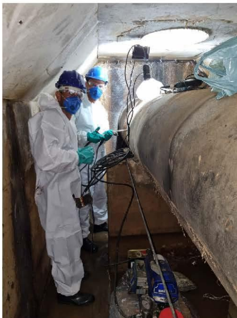
Equipe preparando materiais e equipamentos para injeção
