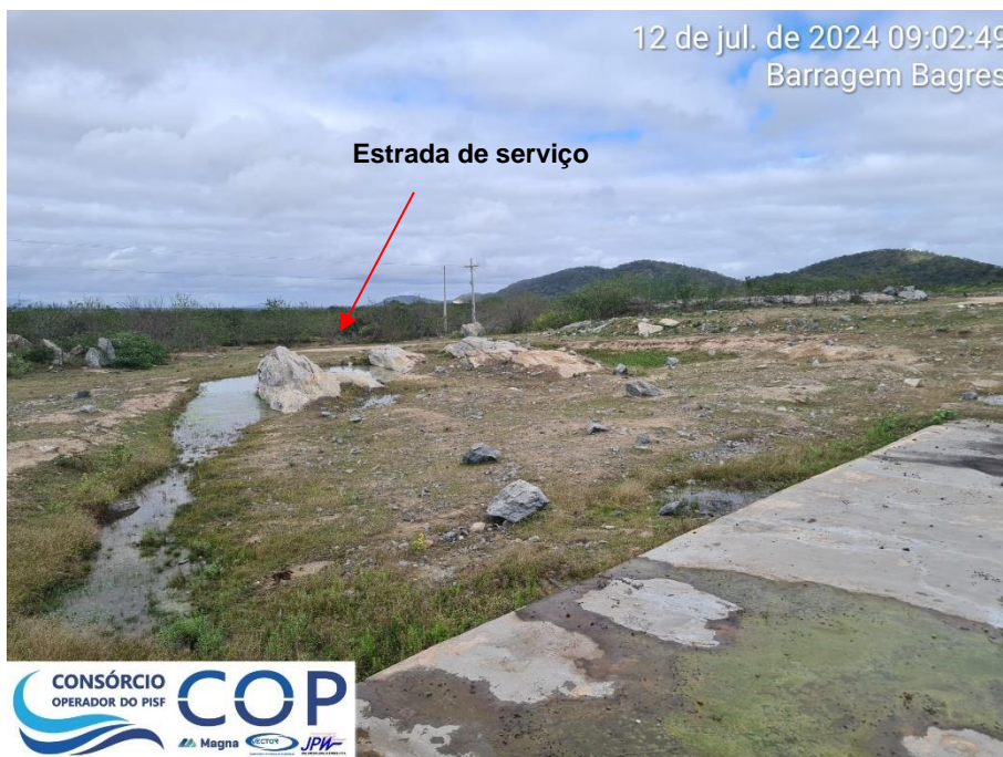
Foto 6.38: Canal de restituição do vertedouro interceptado por estrada de serviço.
