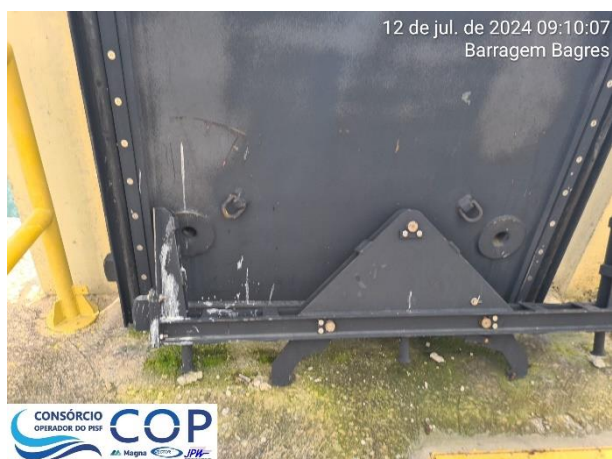
Foto 6.49: Detalhes dos pontos de oxidação na viga pescadora.
