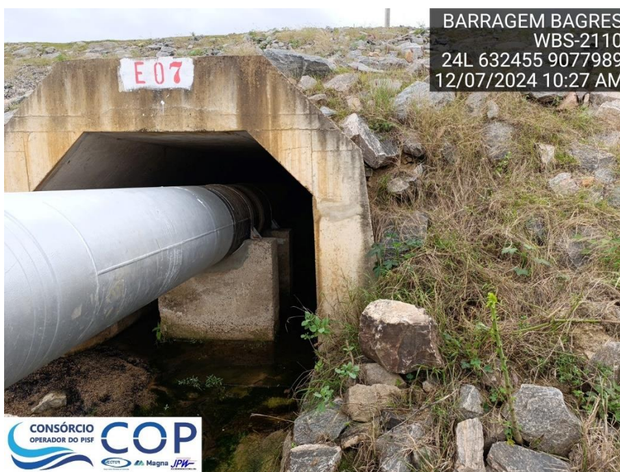
Foto 6.54: Surgência de água no interior da galeria.
