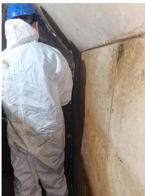
Injeção de gel de poliuretano nos novos bicos para selamento do sistema
