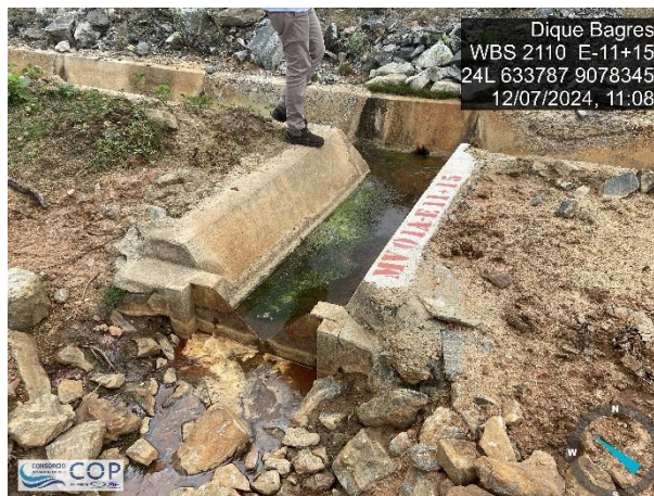
Foto 6.35: Medidor de vazão MV-01A – Estaca 11+15.
