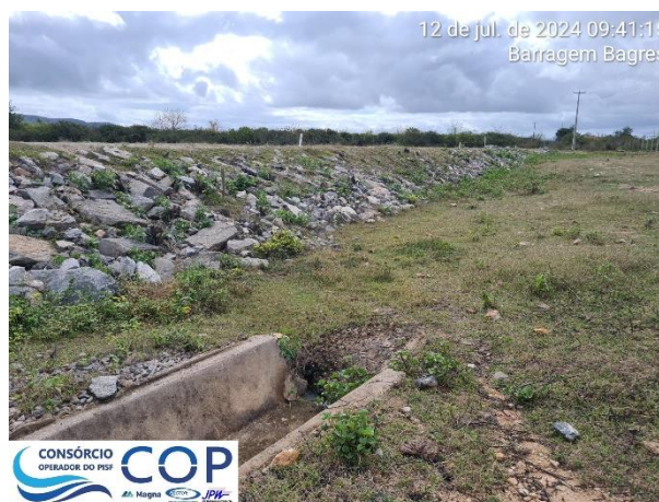
Foto 6.18: Canaleta construída conforme projeto – Ombreira esquerda.
