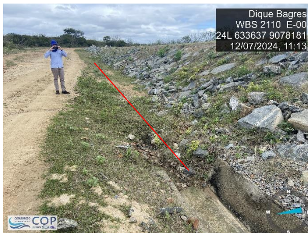
Foto 6.22: Canaleta construída conforme projeto – Ombreira direita.
