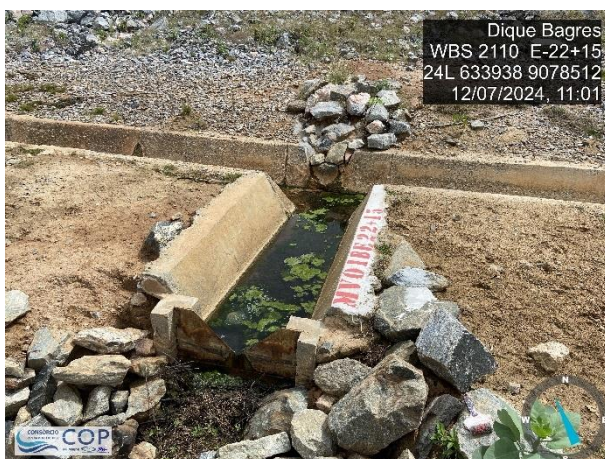
Foto 6.36: Medidor de vazão MV-01B – Estaca 22+15.
