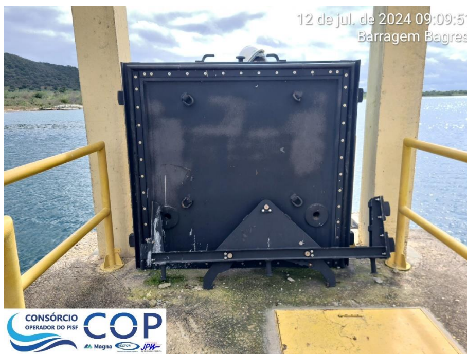
Foto 6.48: Pontos de oxidação na comporta ensecadeira e na viga pescadora.
