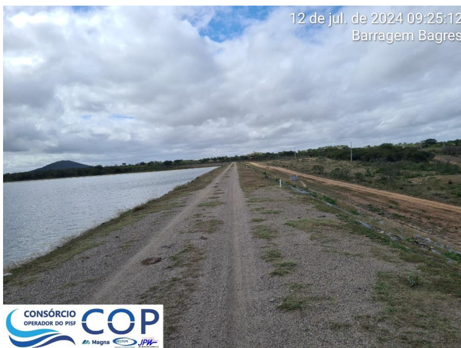
Foto 6.9: Vista do coroamento da barragem. Sinais de tráfego de veículos.
