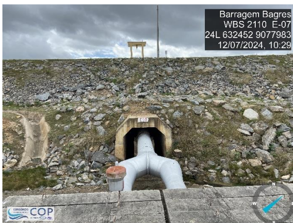
Foto 6.64: Estrutura de saída da tomada d'água.
