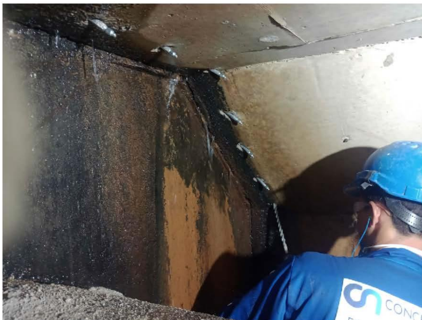
Perfuração do concreto e colocação de bicos para injeção da resina de poliuretano
