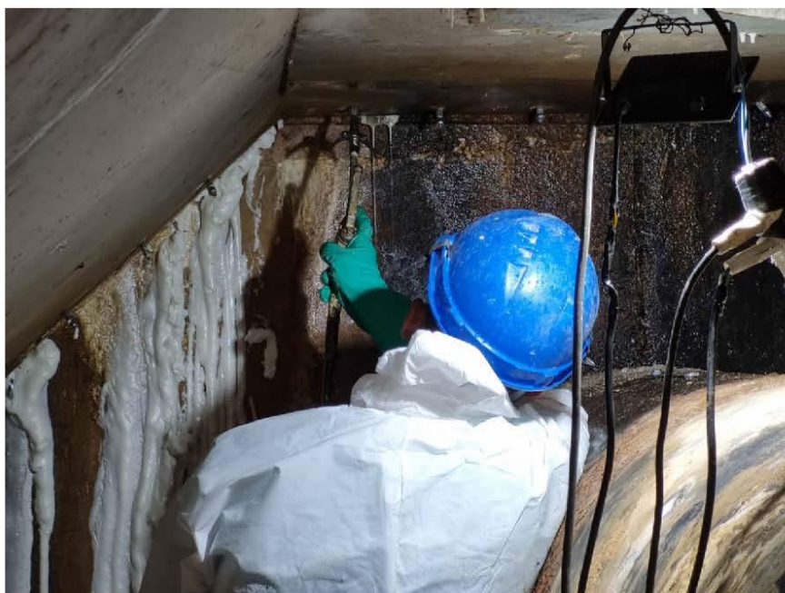
Espuma sendo injetada. É possível ver a formação de espuma ao reagir com a água
