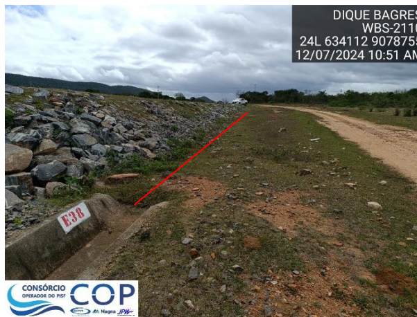
Foto 6.23: Canaleta construída conforme projeto – Ombreira esquerda.
