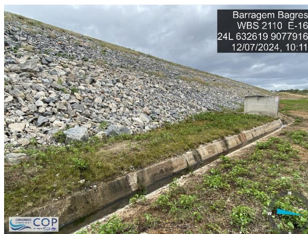
Foto 6.16: Surgências no concreto da canaleta entre as estacas 13+17 e 21+18.
