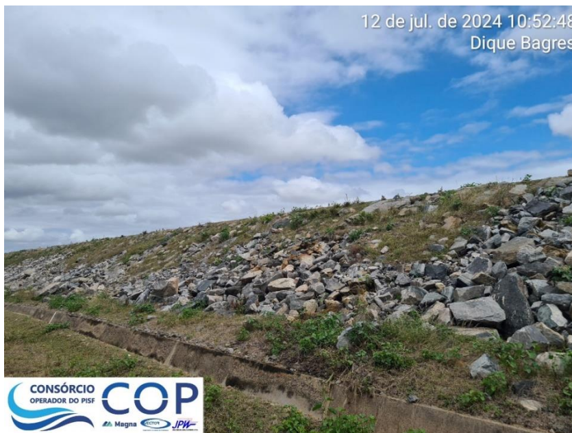
Foto 6.19: Vista do talude de jusante do dique.
