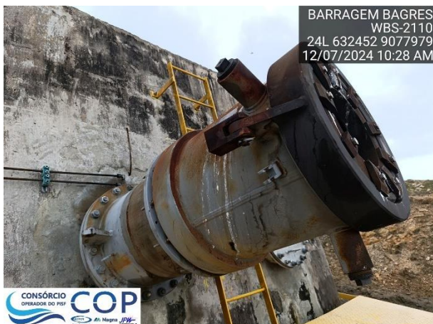
Foto 6.66: Sinais de oxidação na válvula dispersora.
