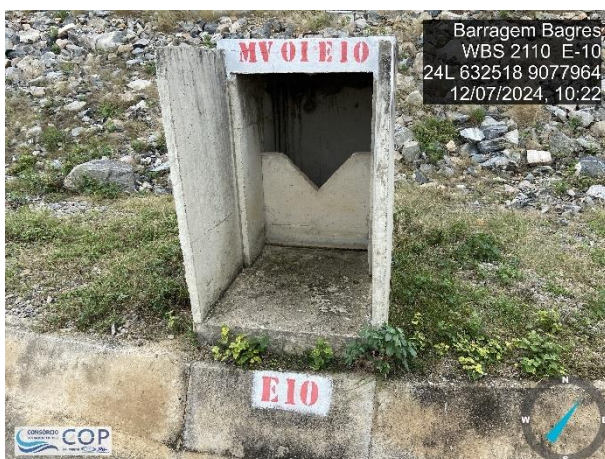
Foto 6.28: Medidor de vazão MV-01 - Estaca 10+00.
