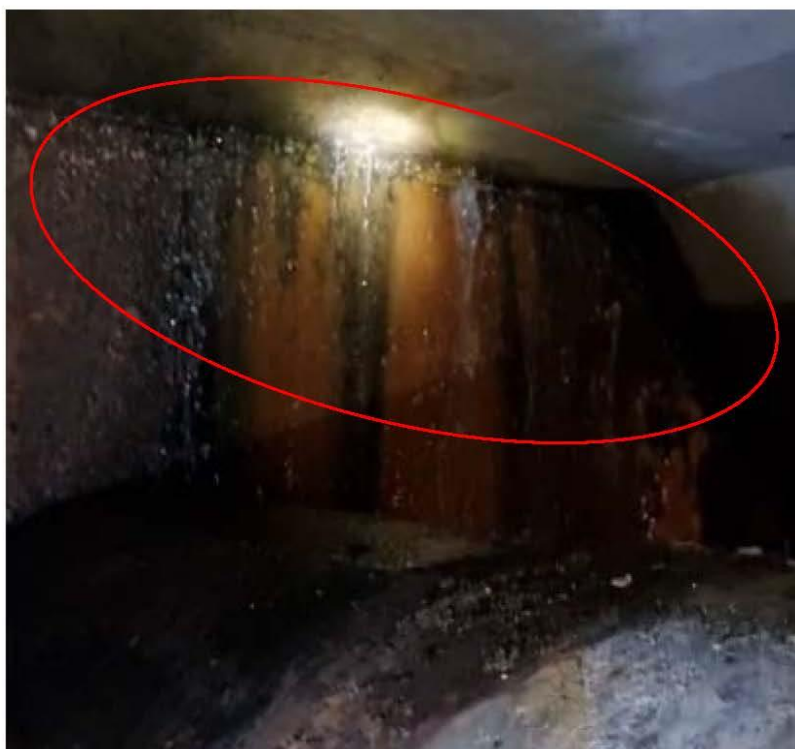
Presença de grande fluxo d'água passando através da junta localizada na parede de fundo da galeria da Barragem de Bagres
