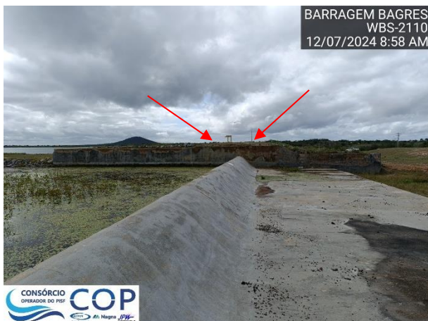
Foto 6.43: Falta de barreira física no muro lateral esquerdo do vertedouro.
