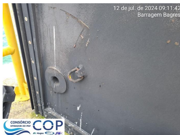
Foto 6.50: Detalhes dos pontos de oxidação na comporta ensecadeira.
