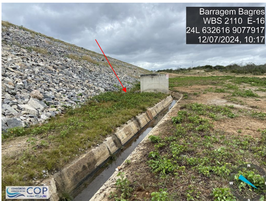
Foto 6.24: Surgências próximo ao medidor de vazão MV-02 na estaca 17+00.
