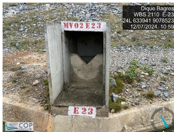
Foto 6.33: Medidor de vazão MV-02 – Estaca 23+00.
