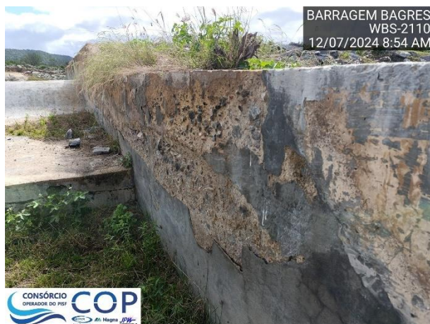
Foto 6.42: Muro lateral esquerdo a jusante do vertedouro, apresentando fissuras superficiais e mal acabamento do concreto.
