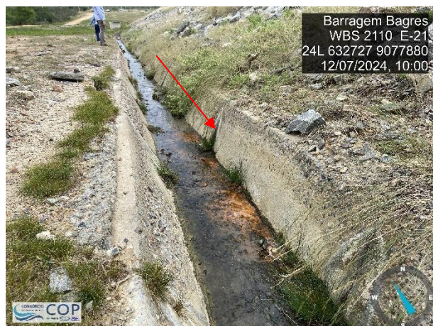
Foto 6.15: Surgências no concreto da canaleta entre as estacas 13+17 e 21+18.
