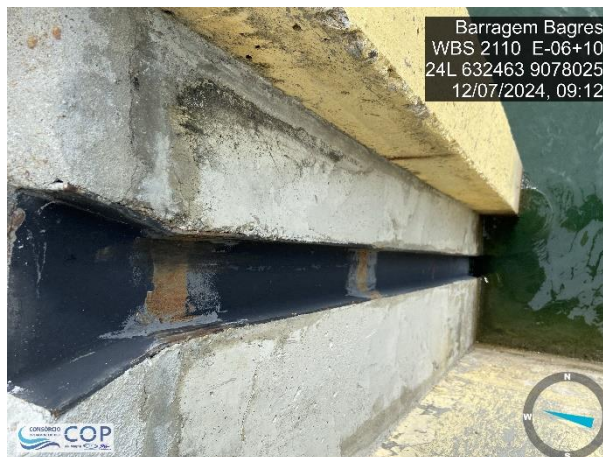
Foto 6.52: Pontos de oxidação nas guias de descida da comporta/grade.
