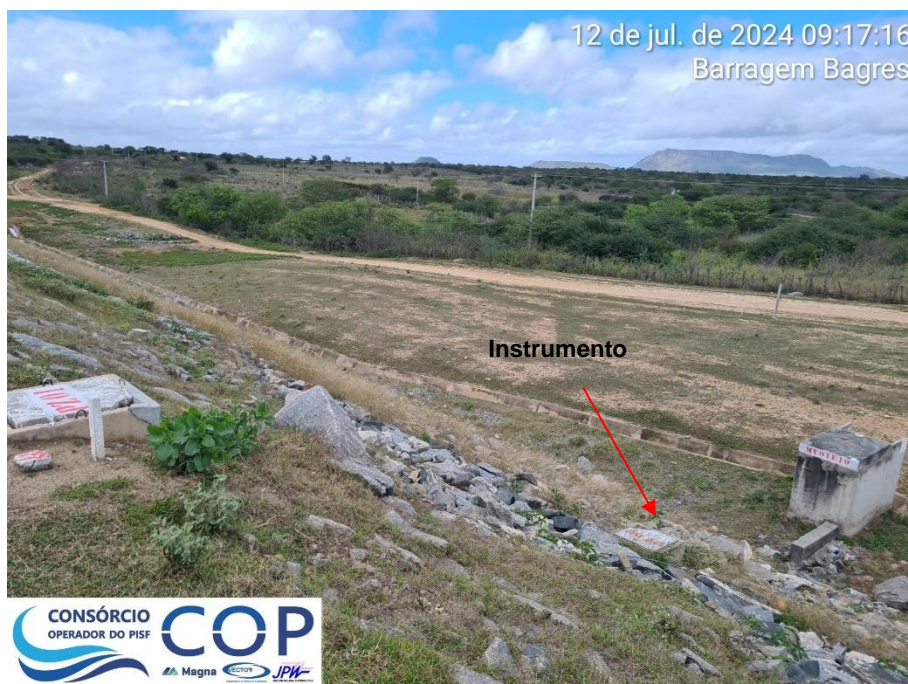
Foto 6.27: Falta de estrutura de acesso aos instrumentos na barragem.
