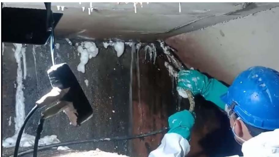
Continuação do processo de injeção de espuma até a obtenção da estanqueidade da estrutura
