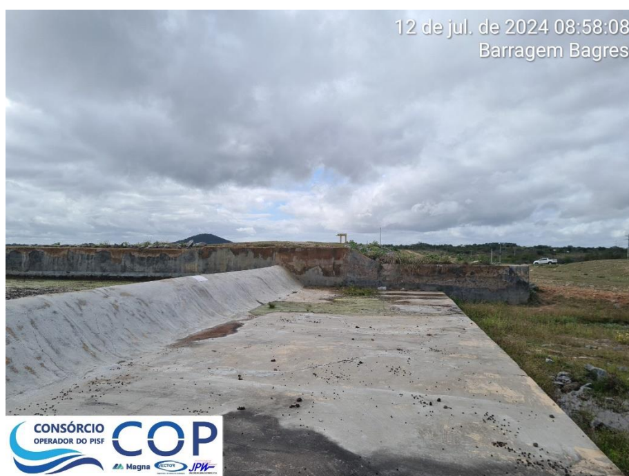
Foto 6.40: Vista da bacia de amortecimento do vertedouro.
