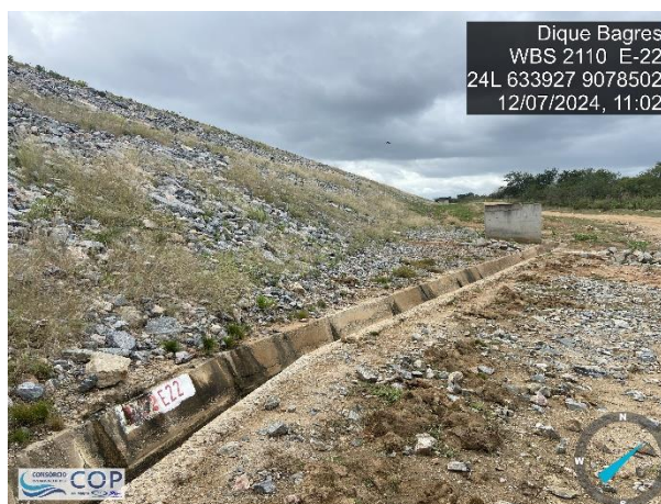
Foto 6.21: Surgência no concreto da canaleta de drenagem entre as estacas 21+10 a 24+00.
