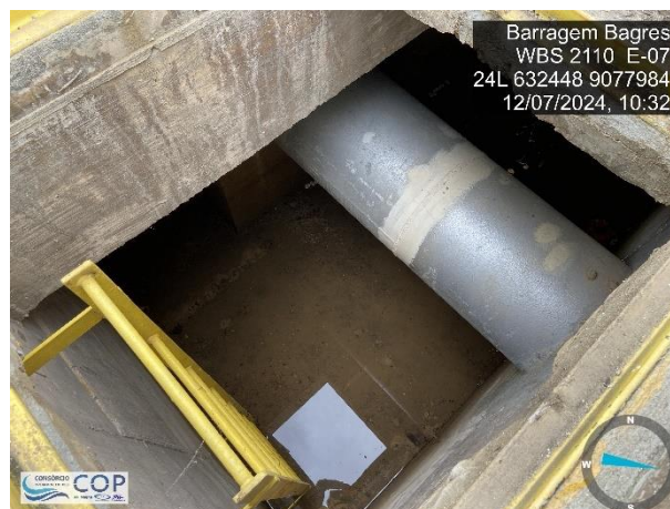
Foto 6.65: Estrutura de saída da tomada d'água.
