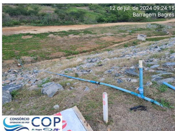
Foto 6.3: Captação de água do reservatório de forma irregular.
