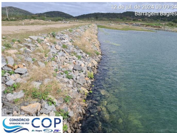
Foto 6.5: Vista do Talude de Montante da barragem.
