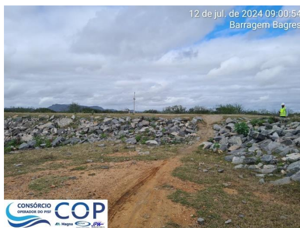
Foto 6.7: Deslocamento do material de proteção no talude de montante, estaca 3P.
