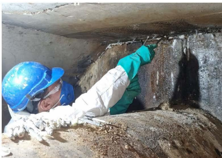
Retirada do excesso de espuma, dos bicos já preenchidos e colocação de novos bicos para injeção com gel de poliuretano na estrutura já estanque
