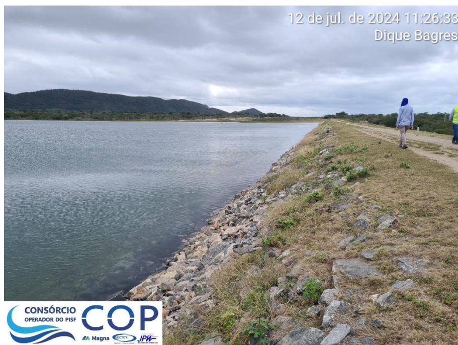
Foto 6.8: Vista do talude de montante do Dique.
