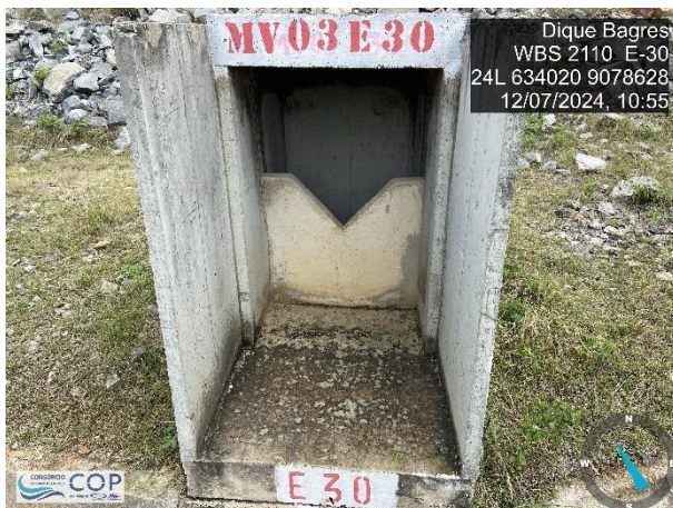
Foto 6.34: Medidor de vazão MV-03 – Estaca 30+00.
