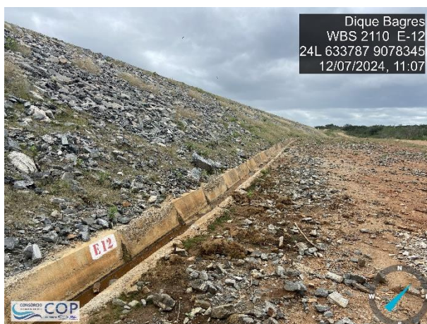
Foto 6.20: Surgência no concreto da canaleta de drenagem entre as estacas 10+00 a 13+00
