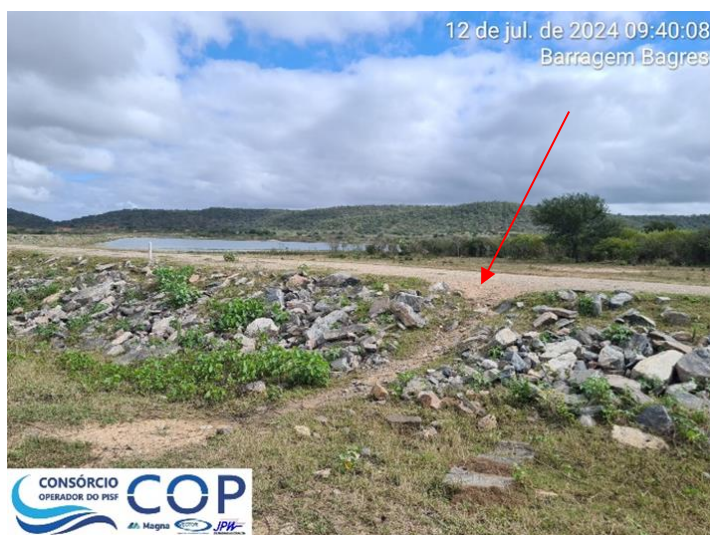
Foto 6.14: Deslocamento do material de proteção causada pela passagem de animais e motocicletas, na estaca 3P.
