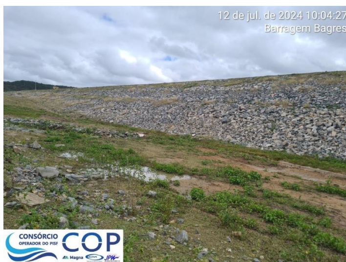
Foto 6.13: Vista do talude de jusante da barragem.
