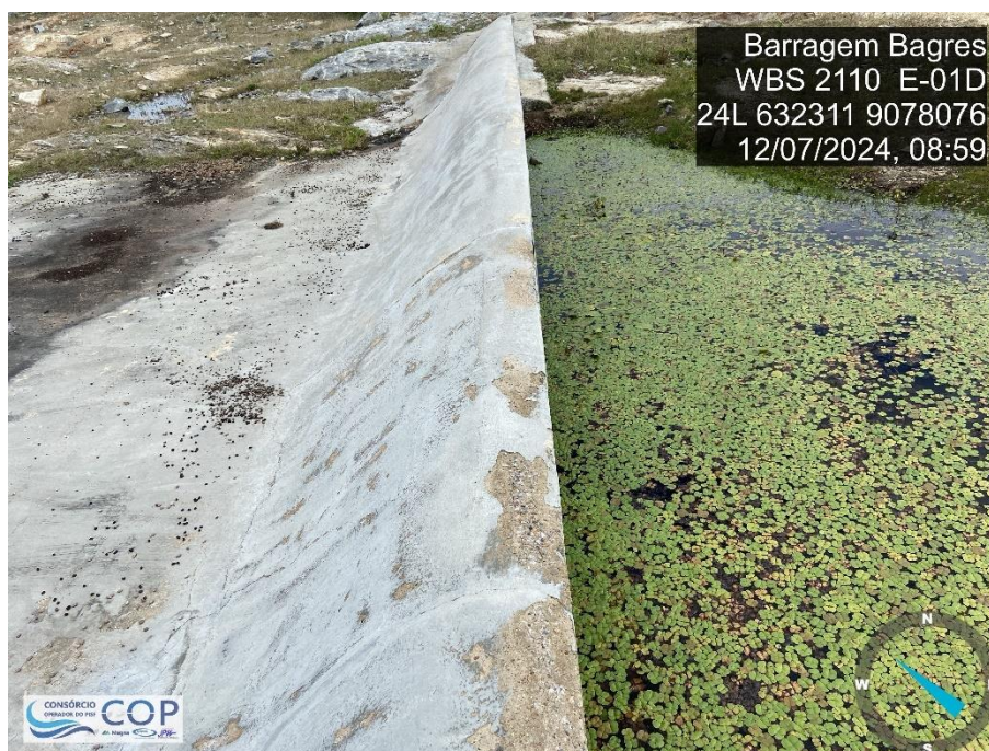
Foto 6.39: Estrutura de fixação do vertedouro apresentando trechos danificados e fissuras superficiais.
