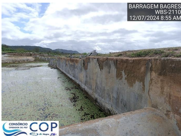
Foto 6.41: Muro lateral esquerdo a montante do vertedouro, apresentando fissuras superficiais e mal acabamento do concreto.
