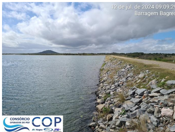
Foto 6.6: Vista do Talude de Montante da barragem.
