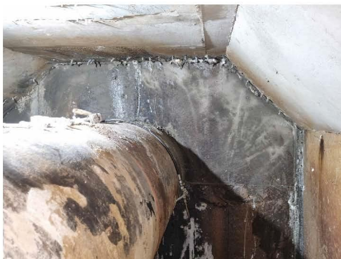
Parede de fundo após a injeção de gel de poliuretano. Vemos ao centro, sobre o tubo, marcas do escoamento do gel já em processo de endurecimento
